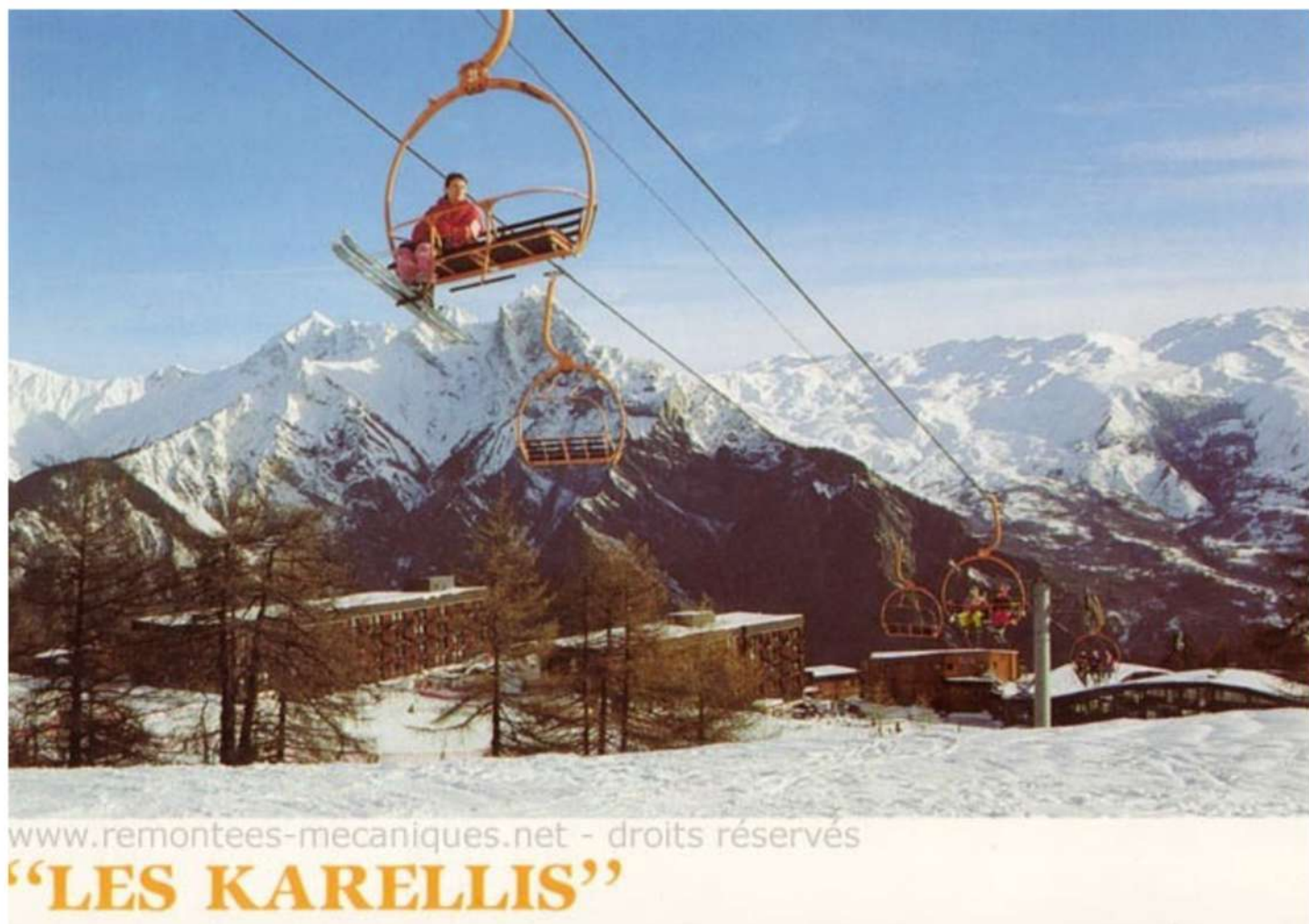
Début de ligne Porte de Brune - 1975 En 2006, le Télésiège de Porte Brune a été démonté.
